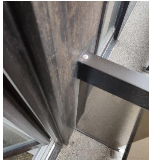
Afb.36. Houten bekleding tussen appartementen
