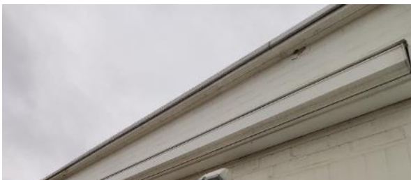
Afb.62. Massieve deksteen en aluminium dakrandprofiel
