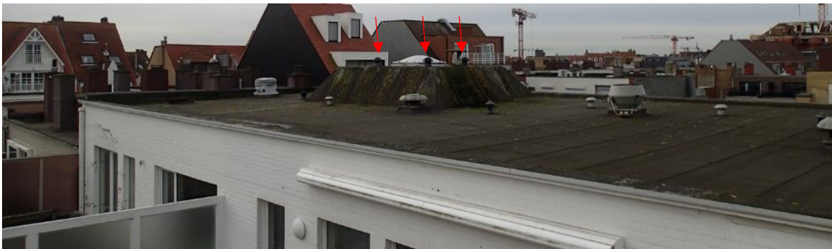
Afb.61. Verluchtingspotjes voor de dakconstructie
