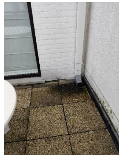
Afb.45. Regenwaterafvoer dak +5
