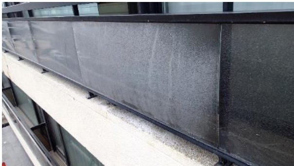
Afb.26. Balustrade met doorgeplooid polycarbonaatplaten
