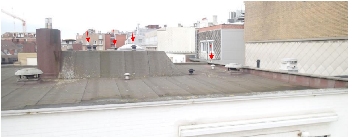
Afb.60. Verluchtingspotjes voor de dakconstructie
