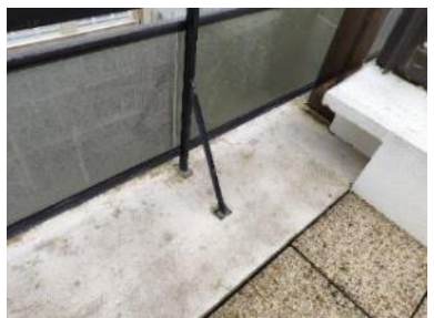
Afb.48. Verankering balustrade doorheen deksteen
