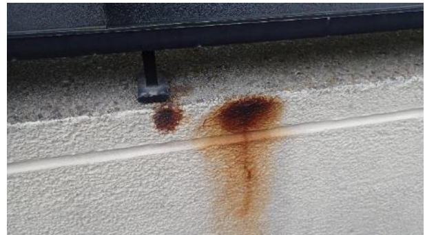
Afb.27. Roest uitlopers in bovenste silexpaneel van terras
