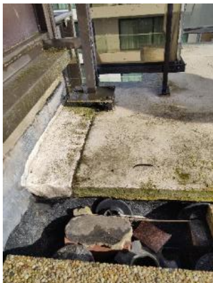
Afb.49. Aansluiting waterdichting dient onder deksteen te zitten, belemmering van RWA
