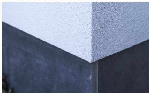
Afb.75. Overgang van het ETICS systeem met een plint in blauwe hardsteen
